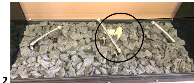
Detail z opačnej strany. Drevo sa nedotýka elektródy.
